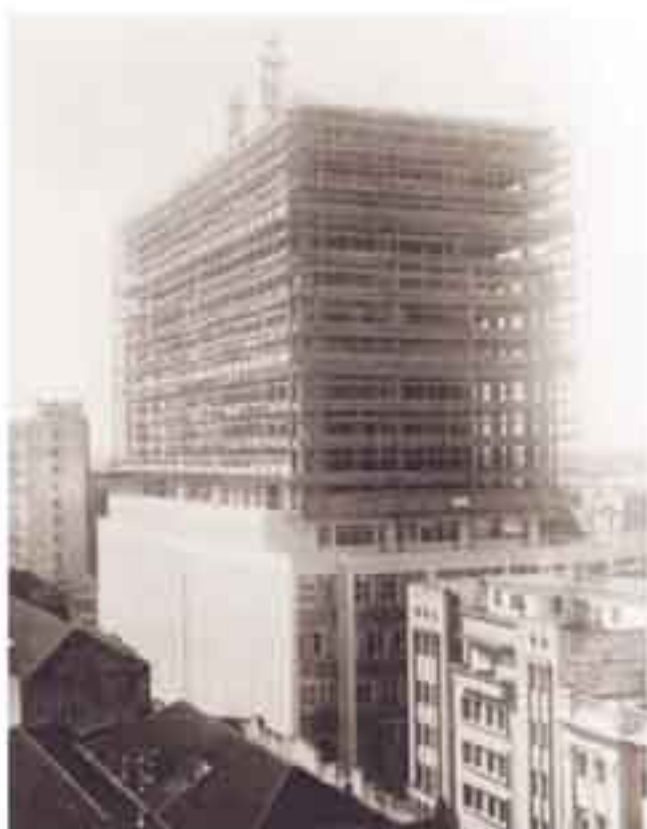
Construção do atual edifício-sede, em Porto Alegre. Fotografia da 18ª laje, em 20 de abril de 1963.
