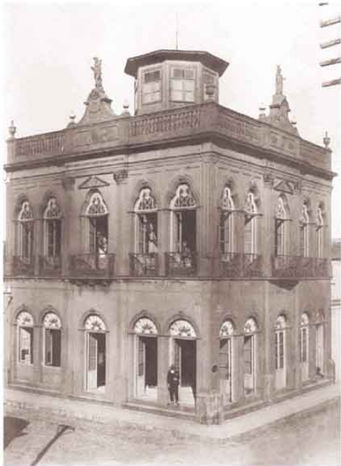
Prédio construído em 1878. Posteriormente, sede da primeira agência de Jaguarão.
